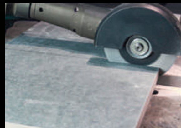
Corte de placas cerâmicas ...
